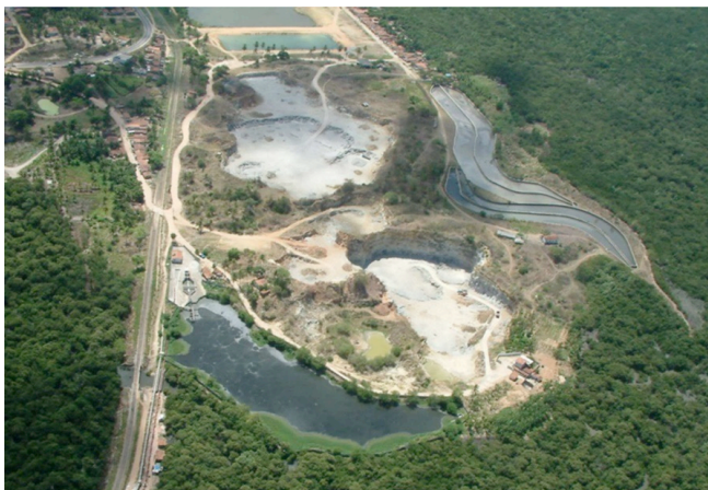
Figura 2. Vista Aérea do Polo de Tratamento de Esgotos do Baixo Paraíba.
